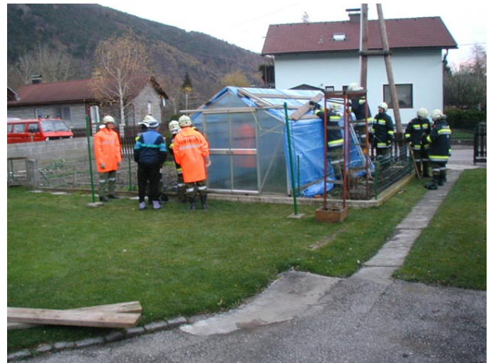
Sichern des Glashauses durch die Feuerwehr
